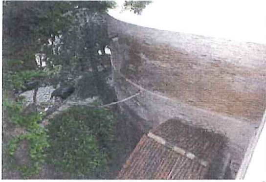
Humedades en el resto del muro del bauarte por posibles filtraciones desde solera superior
