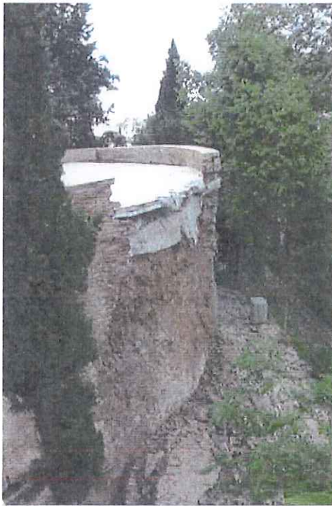
Humedades en el resto del muro del bauarte por posibles filtraciones desde solera superior
