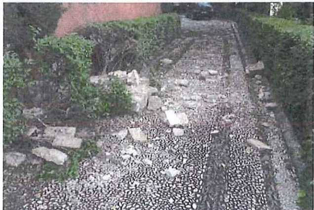
Escombros sobre finca colinadante afectando a acceso y zonas ajardinadas
