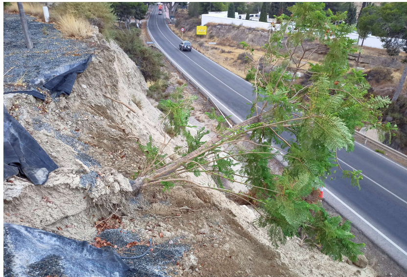
Coronación del talud
