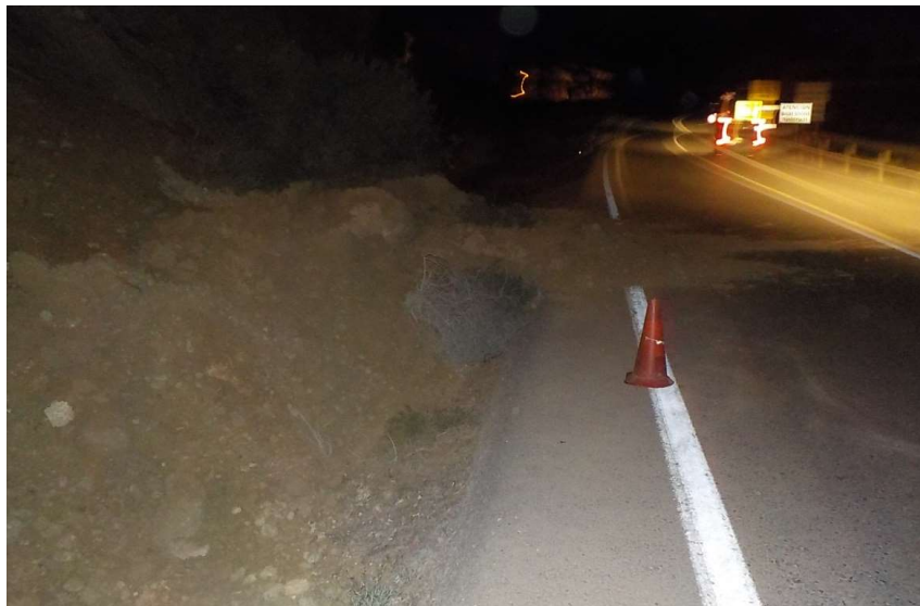
Restos de materiales desprendidos del talud sobre la calzada y la cuneta
