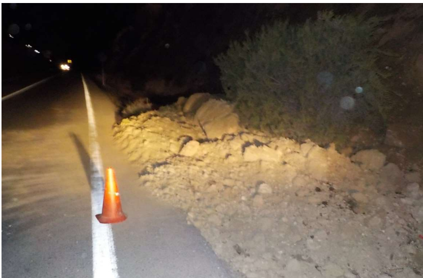
Afección al tráfico por ocupación de la calzada de material desprendido del talud.
