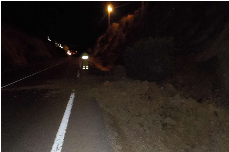
Afección a calzada, carril izquierdo y arcén.
