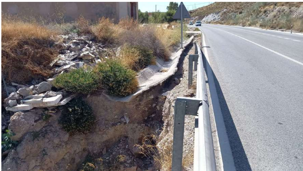
Margen derecho, PK 45+460, a estabilizar con escollera concertada y caedero a continuación de cunetas
