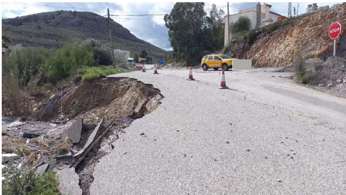
Socavón producido en la entrada a la vía de servicio, zona a recomponer con escollera y pavimento de hormigón
