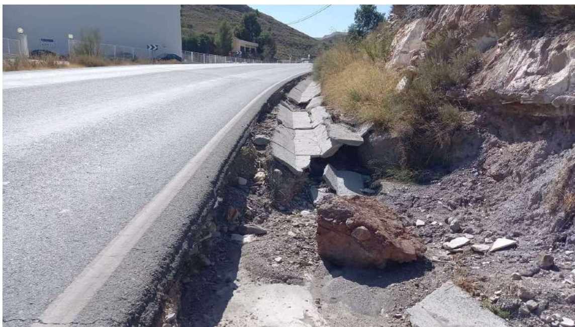
Socavón producido en la entrada a la vía de servicio, zona a recomponer con escollera y pavimento de hormigón
