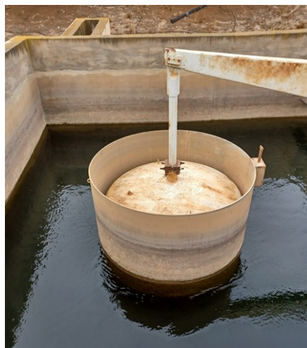
Válvula de flotador reguladora de caudal
