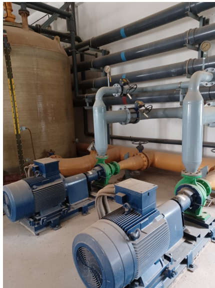
Instalación de desplazamiento y limpieza química
