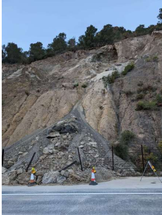
Imagen 3. Vista frontal del desmonte.
