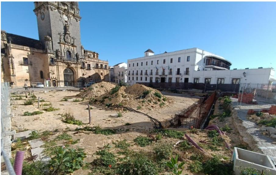
Vista desde el mirador hacia la Basílica Menor de Santa María de la Asunción y el Parador de Arcos. Detalle de armaduras de muro de contención y cuarto de instalaciones en estado de abandono y oxidación.
