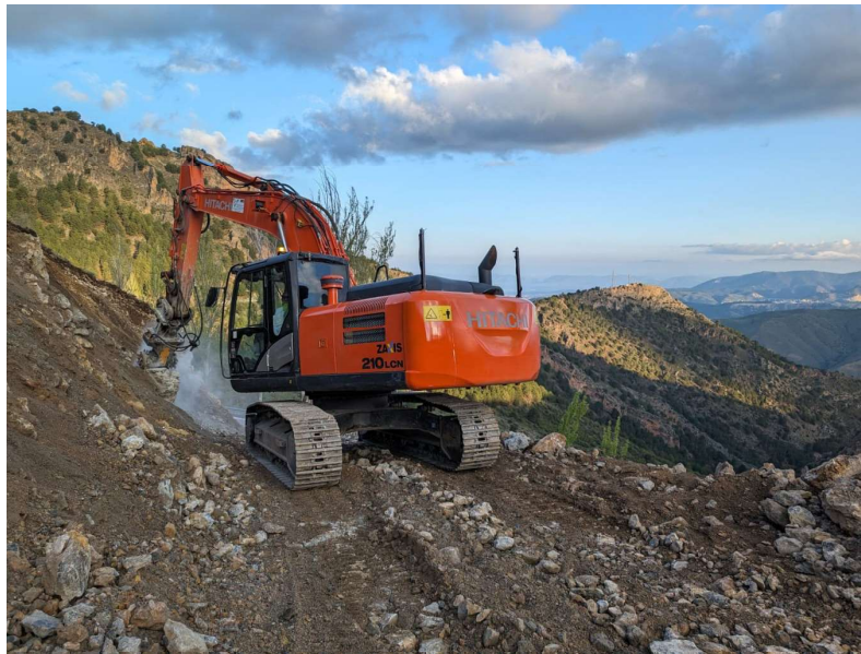
Imagen 6. Máquina rozando piedras con picas de widia por no poder excavar las rocas salientes.
