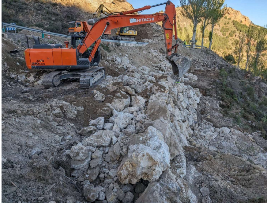
Imagen 5. Escollera de protección de terraplén.
