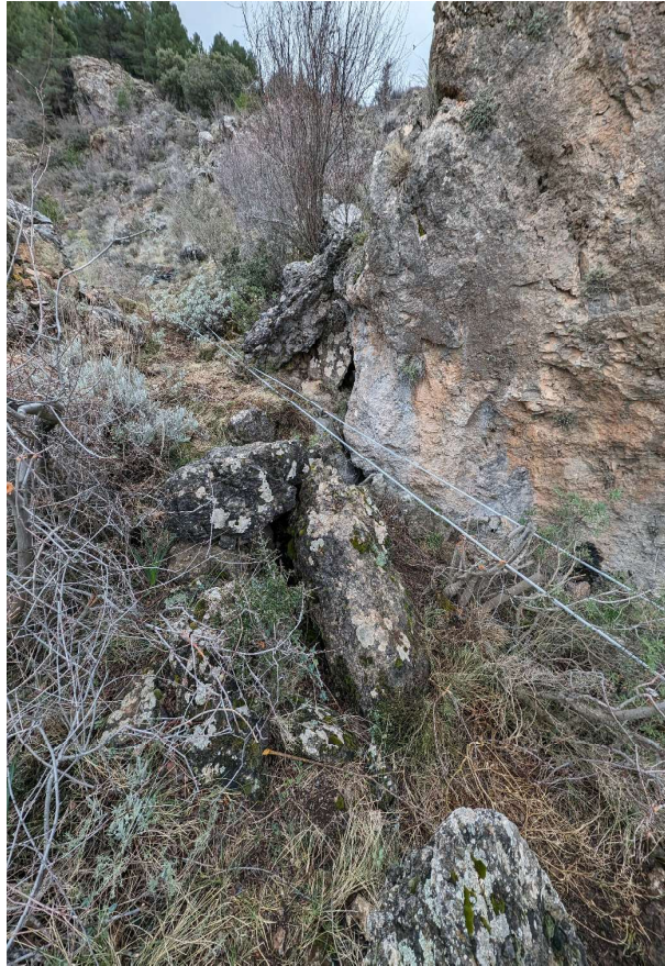
Imagen 4. Cables provisionales para aseguramiento de vialidad en la carretera.
