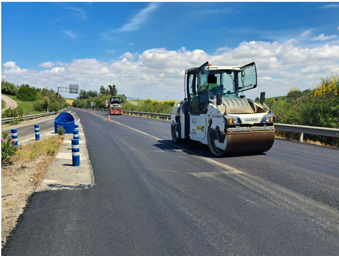
Imagen 3.- Compactación de la capa de rodadura reconstruida.
