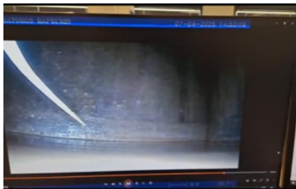
Imagen robot de la toma del desagüe de fondo izquierdo
