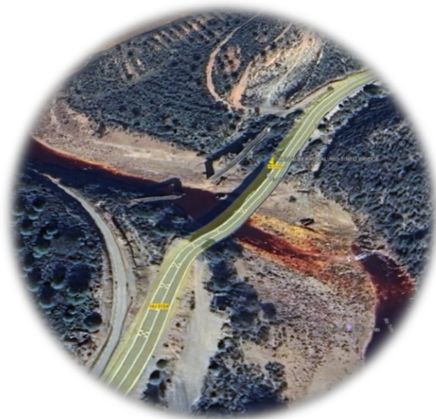
Puente Berrocal (Rio Tinto Bridge)
